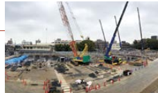
滝子キャンパス 工事の様子
