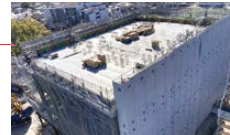
田辺通キャンパス 工事の様子
