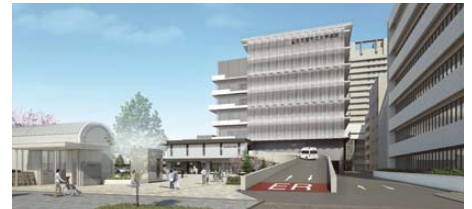
西方面から見る救急災害医療センター
