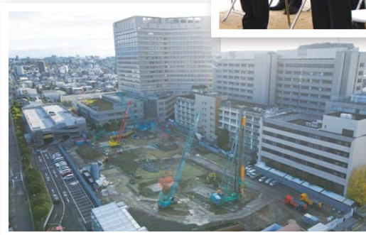
着々と進む建設工事の様子（2022年11月撮影）
