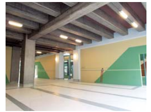
改修後の駐輪場
