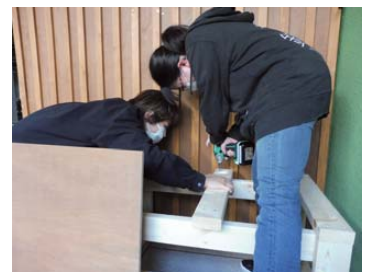
改修作業の様子
