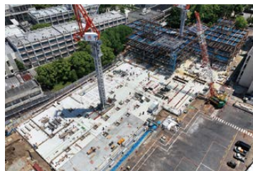
滝子キャンパス工事の様子
