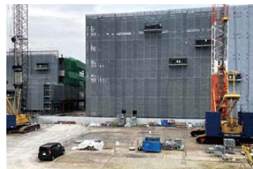
田辺通キャンパス工事の様子
