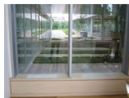
室内のクールチューブ(噴出し)
