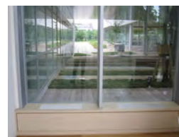
室内のクールチューブ(噴出し)
