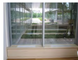
室内のクールチューブ(噴出し)
