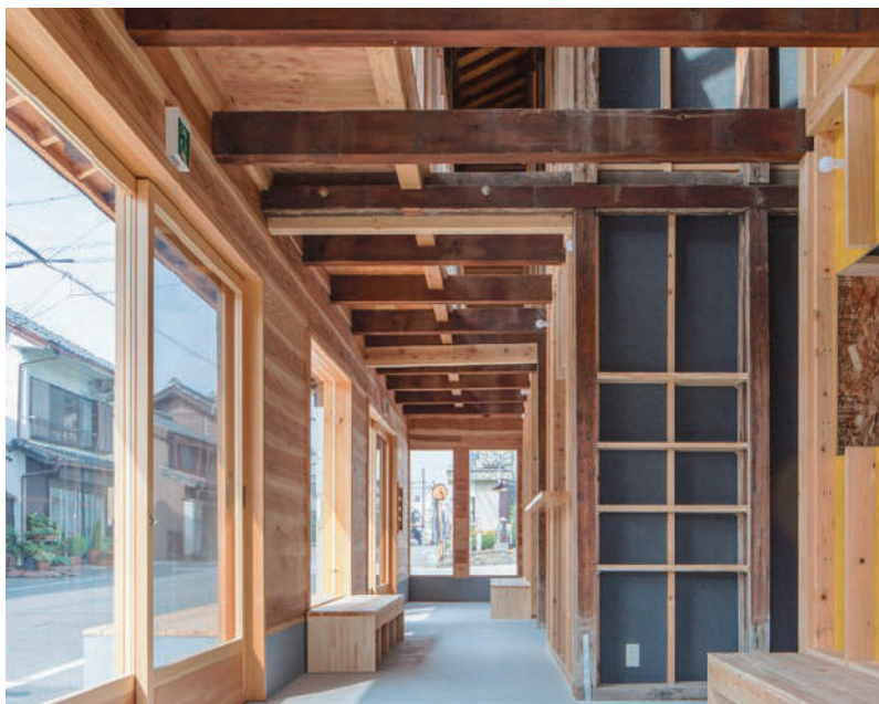
亀崎 3 軒長屋リノベーションプロジェクト 久野研究室 + 旧・寺嶋研究室 ©photo by Tatsuya Noaki
