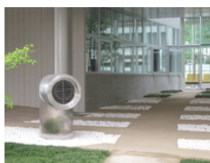
室外のクールチューブ(吸込み)
