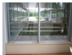
室内のクールチューブ(噴出し)
