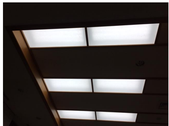
本部棟 4 階ホール照明
